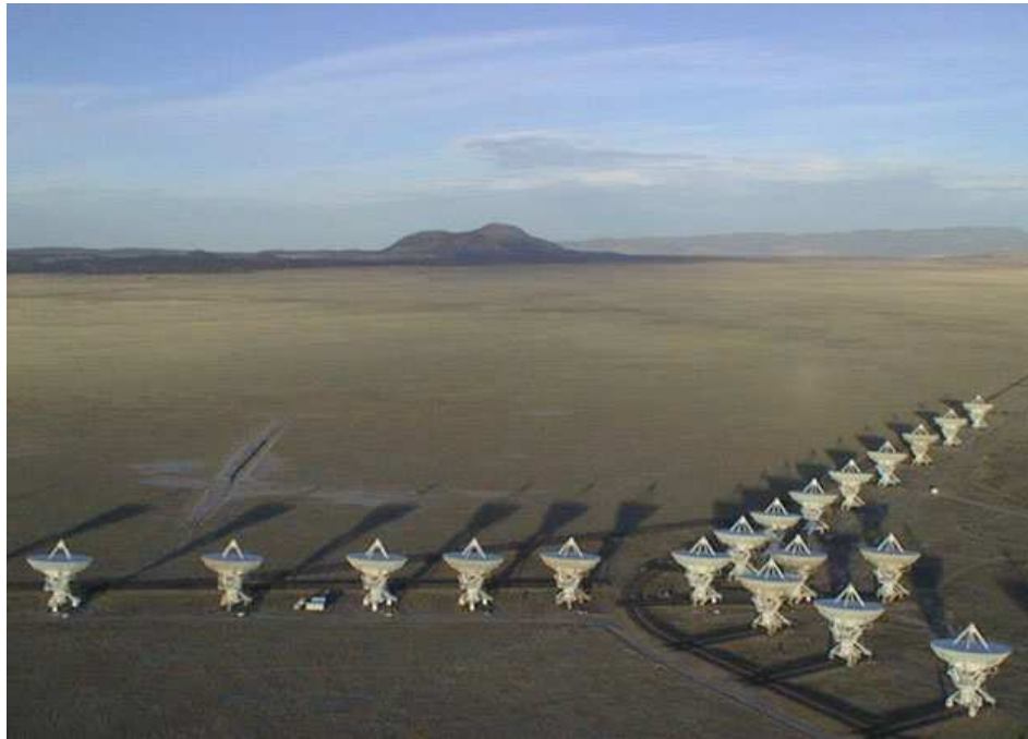
Le VLA (Very Large Array) aux Etats-Unis ; un ensemble de plusieurs radiotélescopes pouvant être utilisés en interférométrie.
